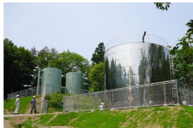
写真：貯湯槽
